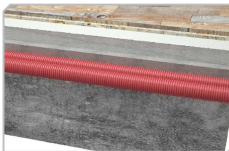
Eingebettet in den Zement (Estrich des Bodens)
